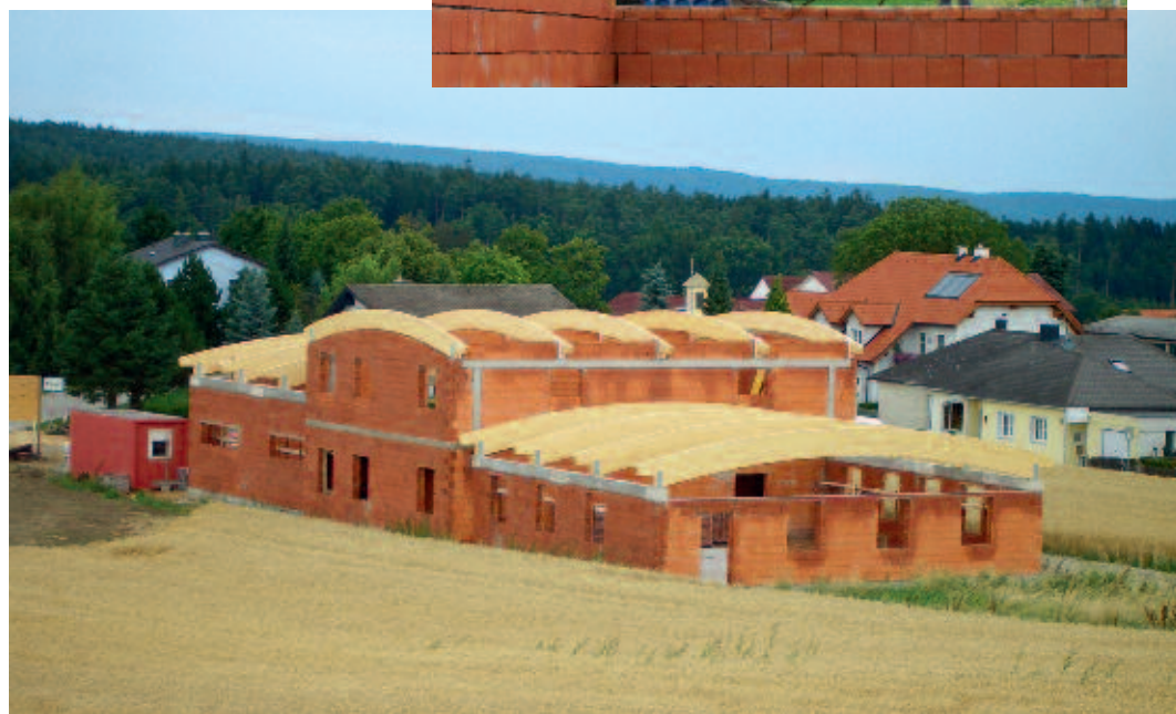
Rohbau des Dorfzentrums, Juli 2010
